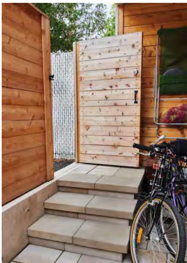
Ce petit espace de rangement devient une véritable merveille, pavé avec le Beacon Hill™ Lisse et des couronnements universels.
